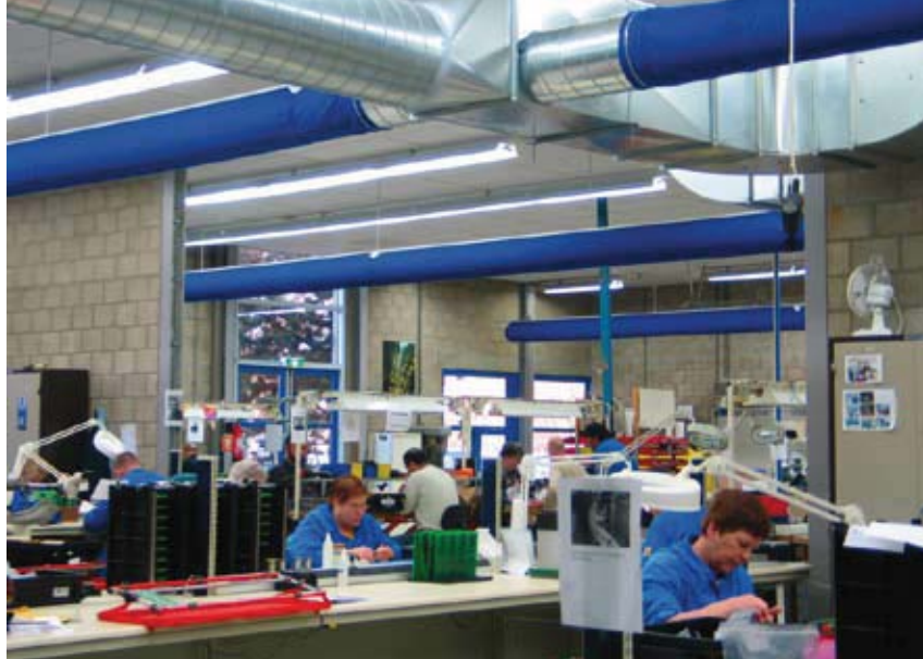
Luchtverdeelslangen in een productie hal bij SWB
