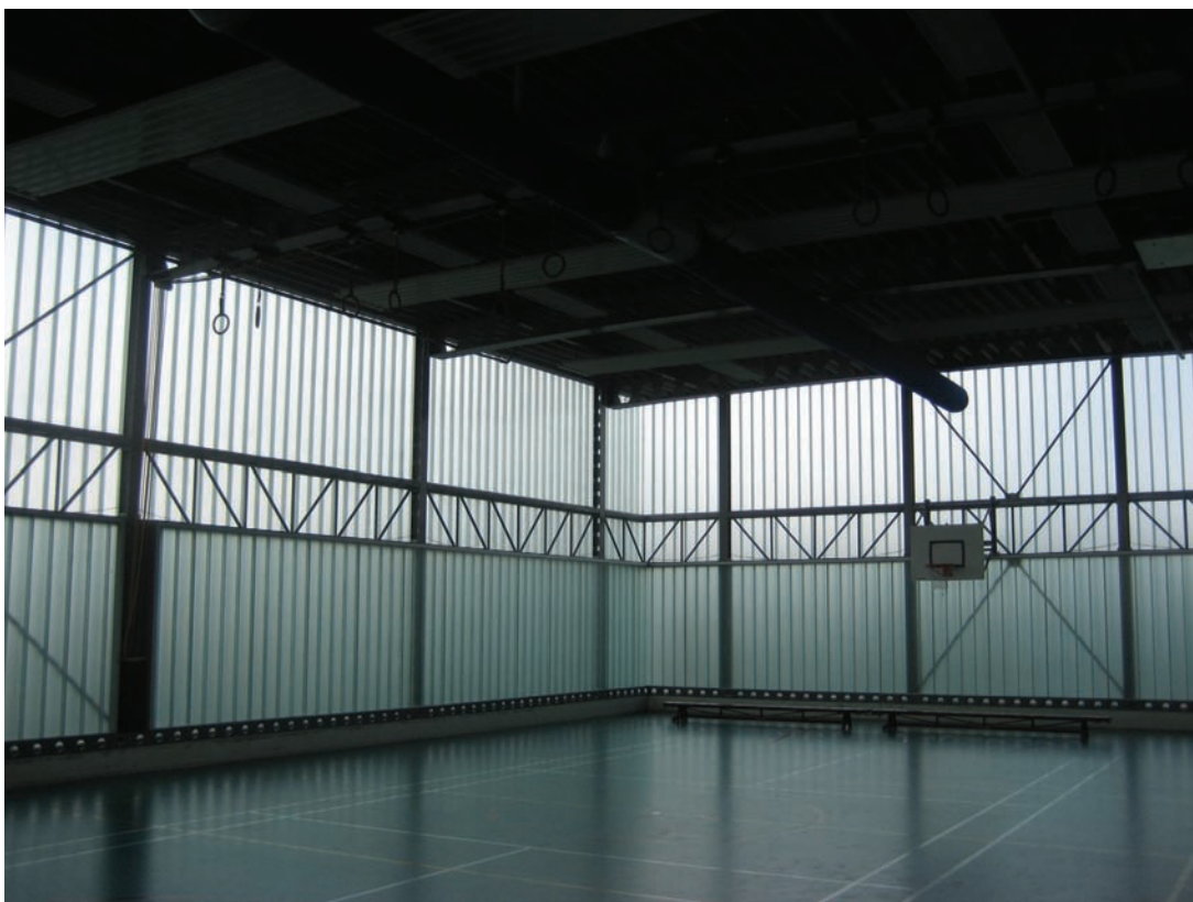
Wanden opgebouwd uit glazen panelen
